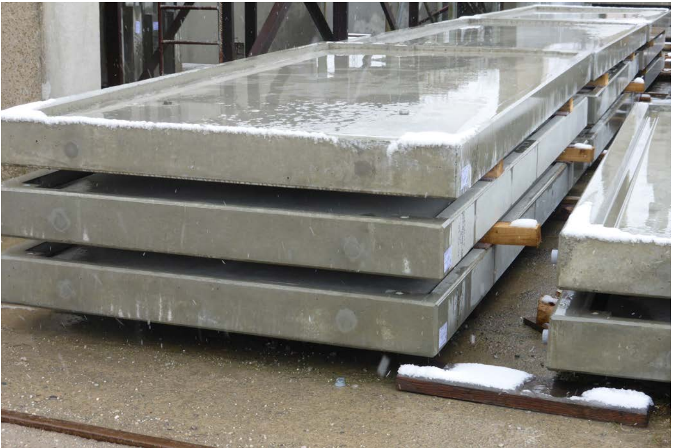
Abb. 3 Lagerung von massiven Betonfertigteilen
