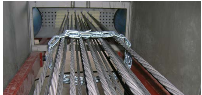
Abb. 30 Absicherung der Spanndrähte durch Ketten
