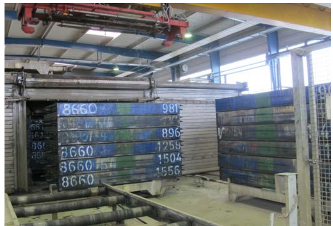
Abb. 77 Verschieben der Schalungen in die Härtekammer
