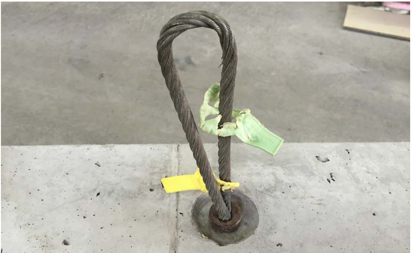
Abb. 33 Transportanker mit Lastaufnahmemittel
