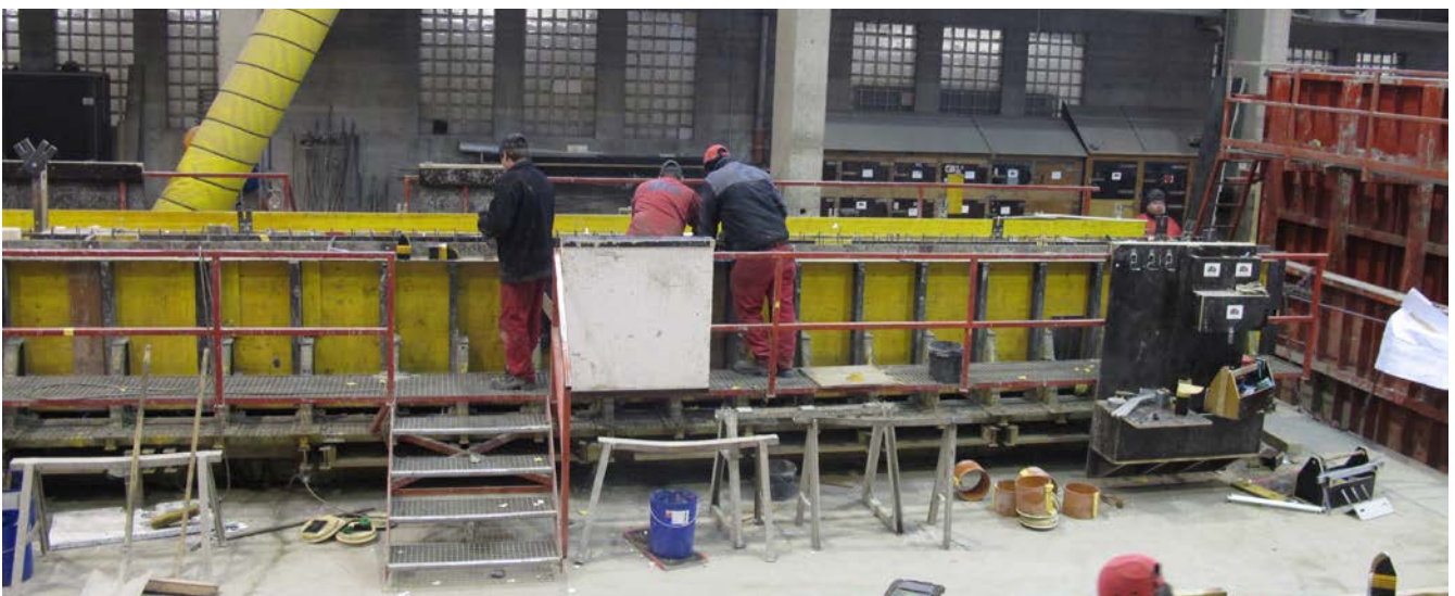
Abb. 32 Betonieren eines Betonfertigteilsbinders mit seitlichen Laufstegen
