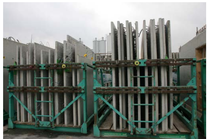
Abb. 5 Gabelagerung von Betonfertigteilen
