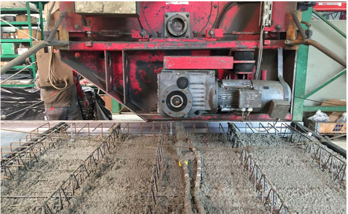
Abb. 9 Personengesteuerte Betonierarbeiten mit Betonverteiler
