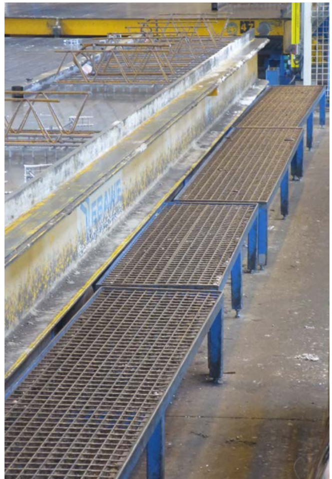
Abb. 8 Podeste auf der gesamten Länge der Paletten
