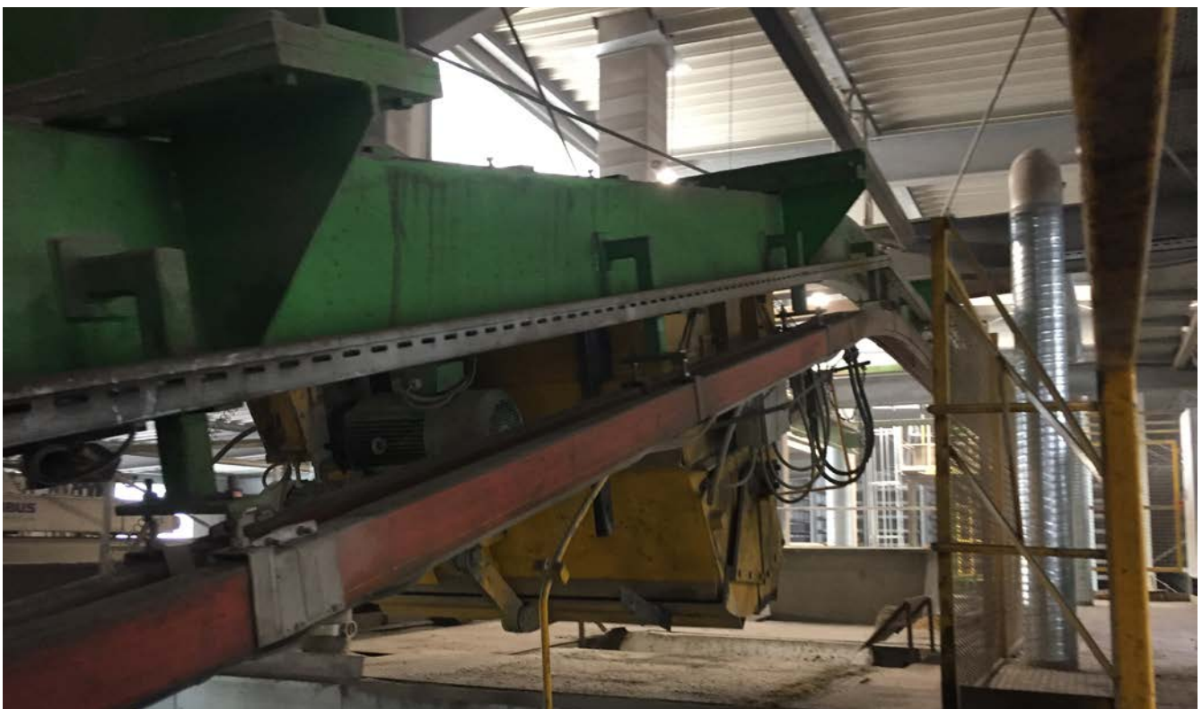
Abb. 102 Betontransport mit Kübelbahn
